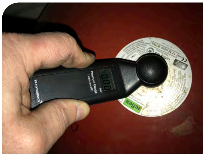
Fig. 19 - Voordrukmeting. Om de voordruk te kunnen meten - die erg belangrijk is - moet het vat dus leeg zijn. Dus heb je een afsluitkraan (kapventiel) en aftapkraan nodig
